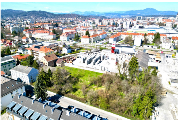
Blick Richtung Norden
